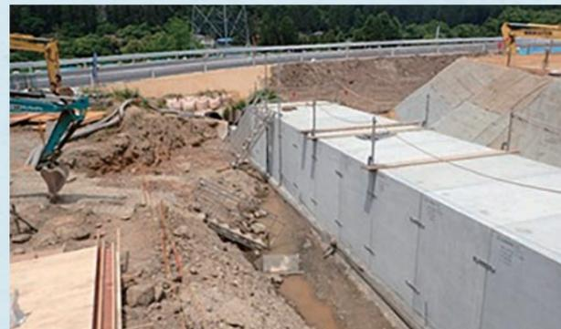
東側の斜面の水を流す横断ボックス(令和2年6月)
