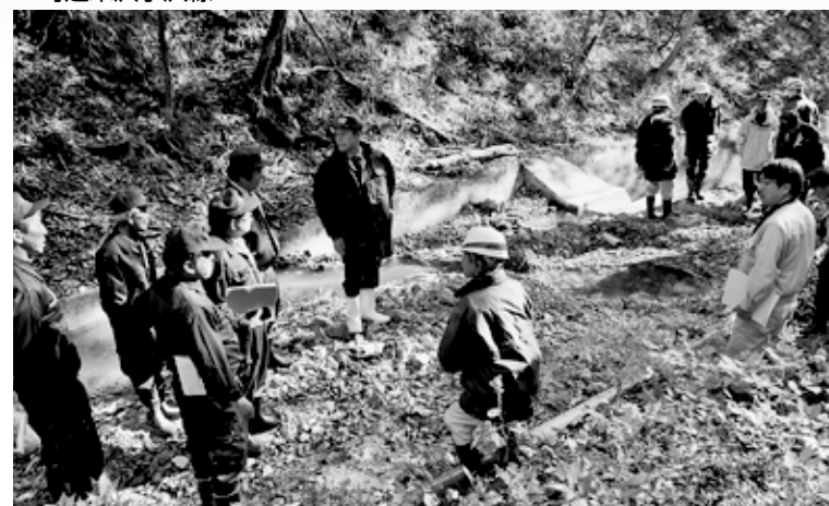
▲青根第2浄水場取水口
