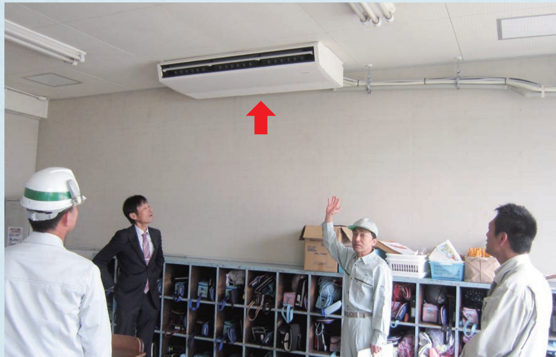
すべて三菱の機種を使用、これは天つり型。5月9日午後1時頃 川崎小
