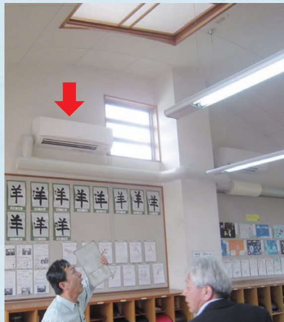
天窓と横窓からの光が室温を上昇させていた 富岡小2階の教室
