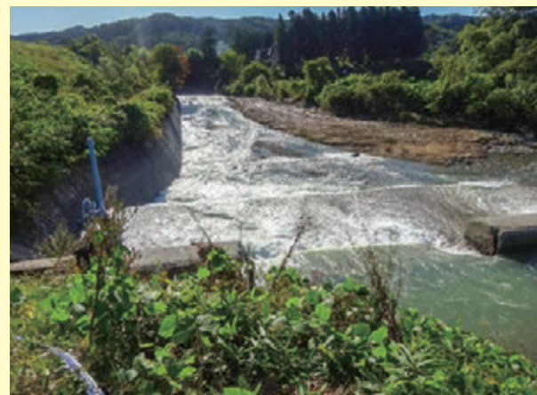
▲堰体が流されて取水できない状況になりました。 (山の神堂頭首工：前川)
