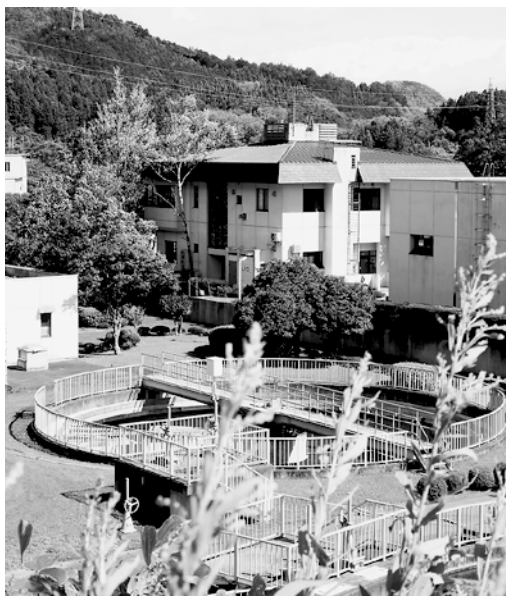
▲老朽化が進む浄化センター
