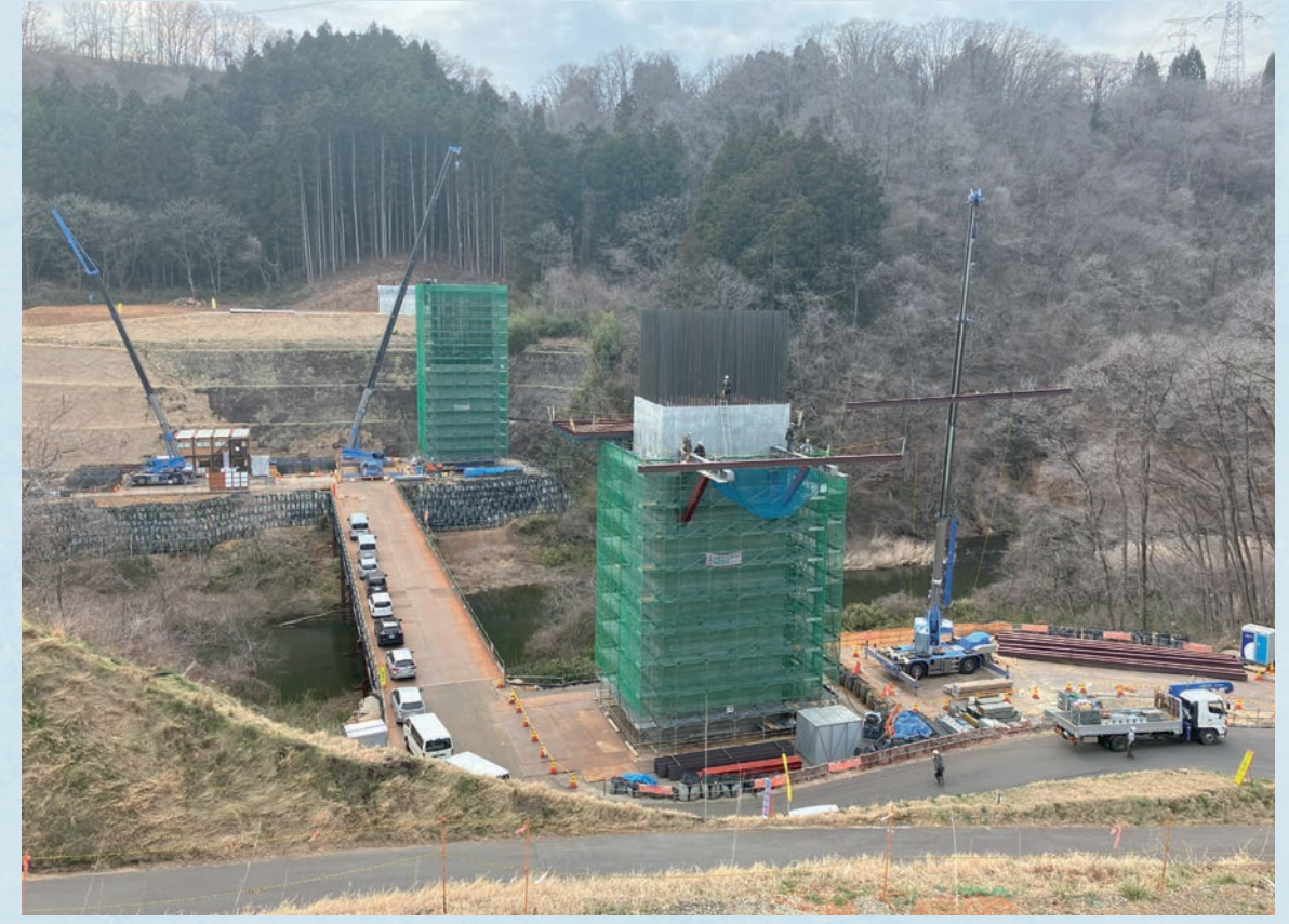
仙台市の工区。通称「1号橋」の現場。手前が赤石側、碓石川の向こうが川崎町側。全長207メートルの橋をかける。現在、橋脚2基、橋台2基が完成し、橋の桁工事に着手しています。来年3月の完成を目指しクレーン車3台が資材を移動中。なお、写真は3月10日に小山町長が撮影したもの。
