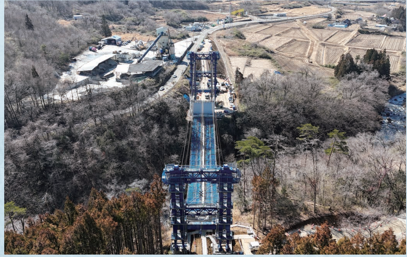
碓石・川向地区より仙南生コン様・プラント方面を臨む。写真は3月10日の状況。通称「3号橋」は宮城県の担当。2つの橋台は完成しており、その距離は約93メートル。現在、橋桁材を吊るクレーン用の鉄塔の建設をしており、間もなく桁の架設作業に入り、来年3月の完成予定。橋ができれば延長618メートルのトンネル工事に着手する運びです。
