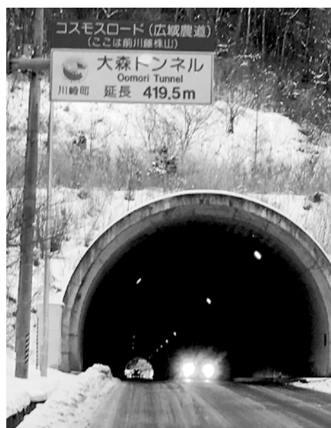
▲改修が待たれる大森トンネル照明
