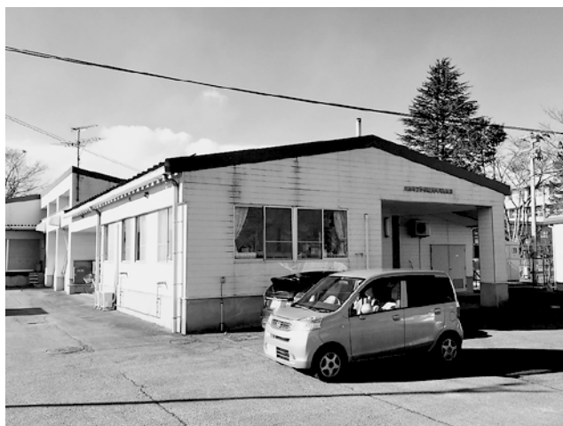
▲建設から27年目の調理場
