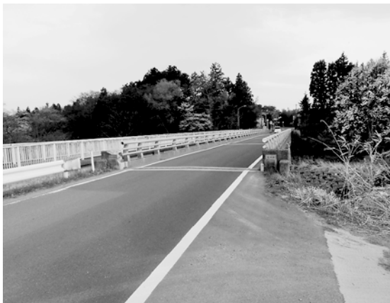
▼改修がされた並行する北川橋
