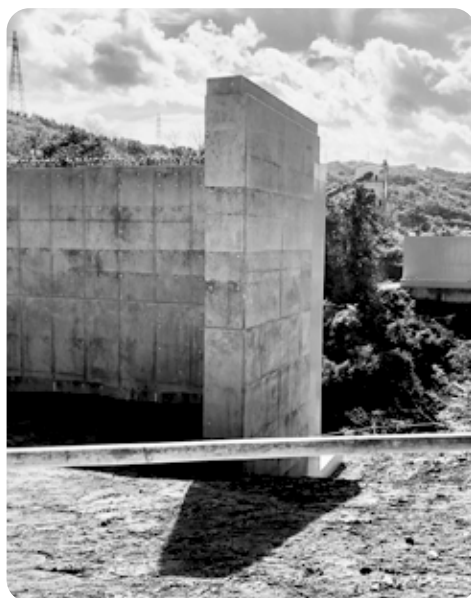
▲碓石工区橋台
