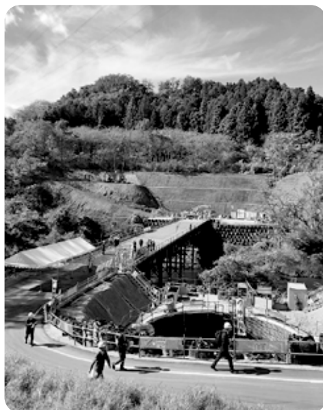
▲南赤石工区工事用仮橋
