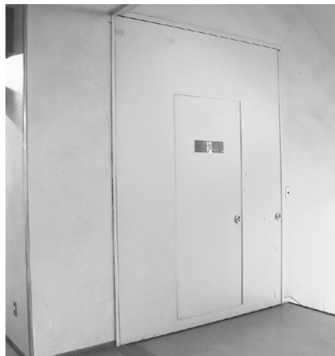
▲防火扉の改修へ
