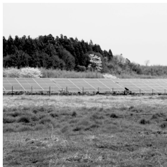
▲設置が進む太陽光
