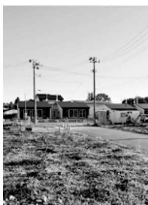
▲整備が進む町営住宅
