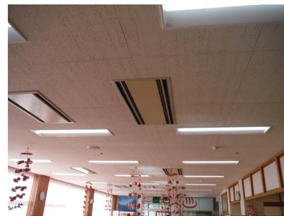
写真：事務室や長時間使用する部屋の照明をLEDに変更
