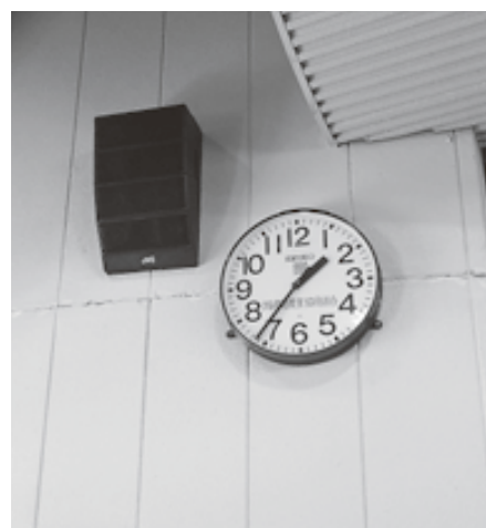
▲横一直線の亀裂
