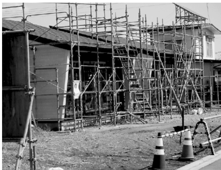
▲建設が進む町営中原住宅
