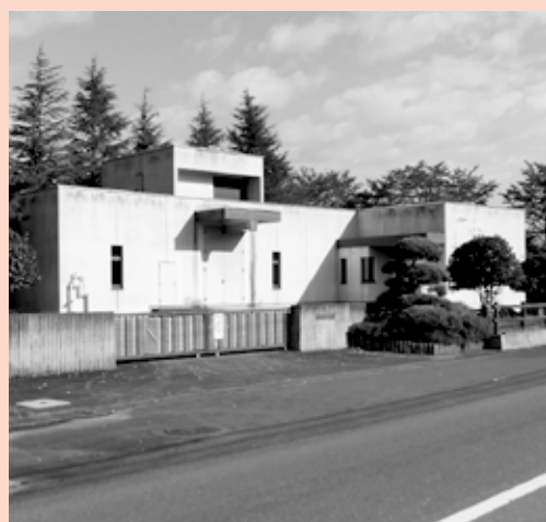
▲大針中継ポンプ場
