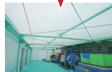
プール・建物間通路
